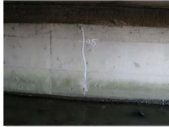
・橋台前面に、幅0.5mmのひび割れが生じている。
