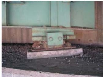
・支承の塗装が劣化し、表面錆が生じている。
