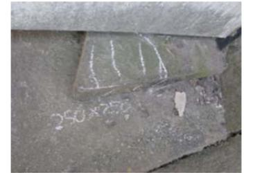
・沓座モルタルの端部に浮きが生じている。
