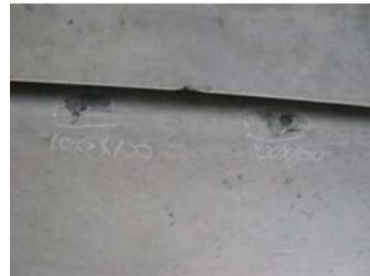
・主桁の角に欠損が生じている。
