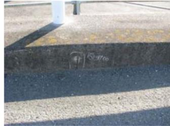
・地覆内側に剥離・鉄筋露出が生じている。
