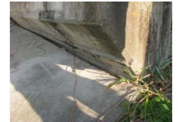
・橋台前面の護岸が沈下し、空隙が生じている。
