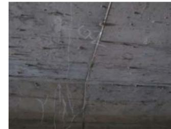
・主桁下面に、幅0.2mmのひび割れが生じている。
