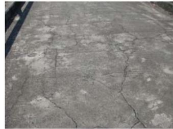
・舗装表面にひび割れが生じている。
