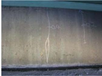
・胸壁前面に幅0.2～0.4mmのひび割れが生じている。
