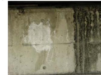
・橋台前面に幅0.2mmのひび割れが生じている。
