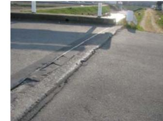
・橋台背面に3cm程度の段差が生じている。
