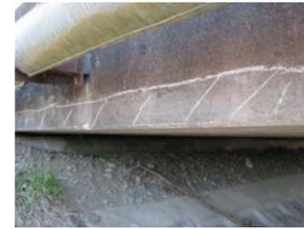
・主桁側面のカバーコンクリートにうきが生じている。
