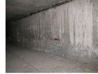
・伸縮装置から漏水が生じている。
