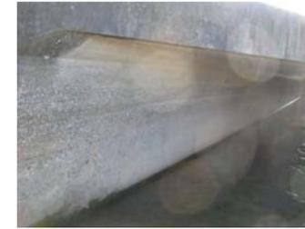
・橋台前面に、河川の影響による磨り減りが生じている。
