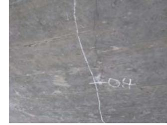
・主桁下面に、幅0.4mmのひび割れが生じている。
