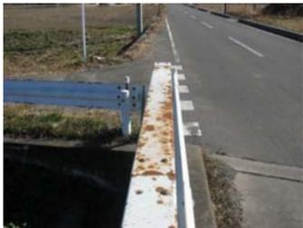
・防護柵（ガードレール）の防食機能が劣化し、部分的に錆が生じている。
