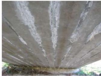
・桁間詰め部から遊離石灰を伴う漏水が生じている。
