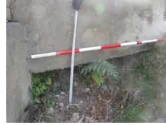
・袖擁壁下端部に洗掘が生じており、路面の沈下に進んでいる。
