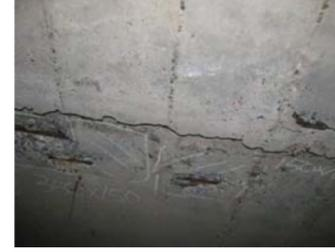
・主桁下面に、うき・剥離・鉄筋露出が生じている。
