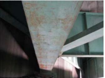
・桁端部の塗装が劣化し、下塗りが露出している。
