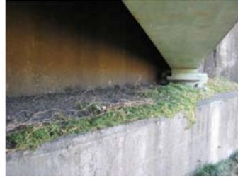
・伸縮装置からの漏水と橋座への土砂堆積が生じている。
