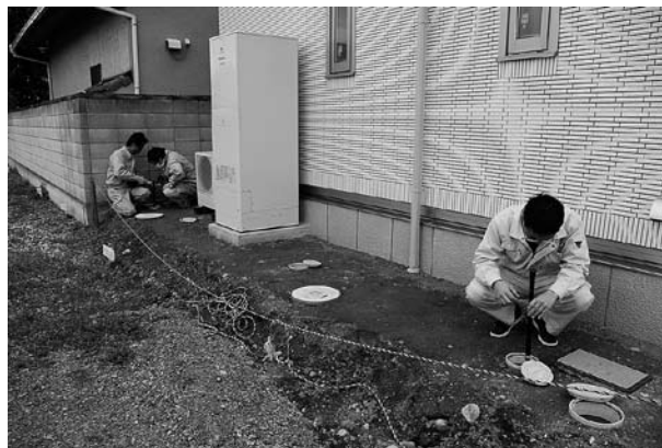
排水設備工事完了検査状況
