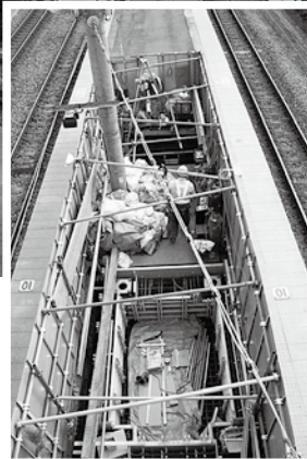
エレベーター設置工事の様子(平成23年3月完成予定)
