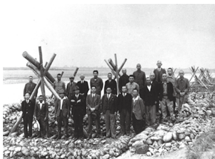
護岸工事（昭和27年）
