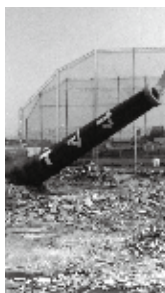
倒された大和の煙突 (昭和57年)
