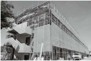
改築中の上里中学校
