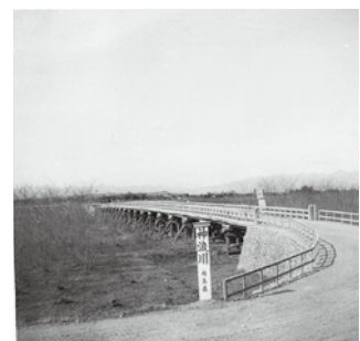
藤武橋 (昭和32年)
