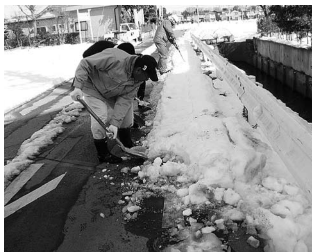
職員による通路路の除雪作業
