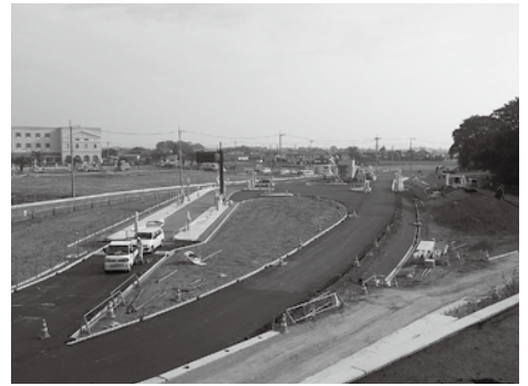
開通に向けて工事が進んでいます
