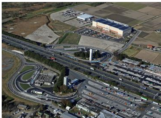
発展が期待される上里サービスエリア周辺地区
