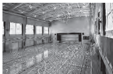
改築が完了した 上里中学校屋内運動場
