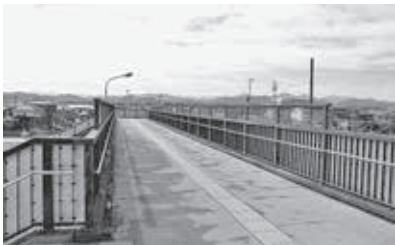
改修予定の神保原駅南北自由通路
