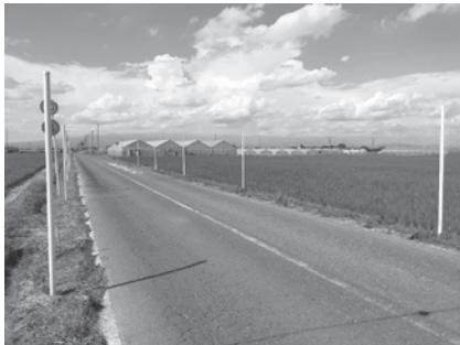
▶設置した「視野対策ポール」
