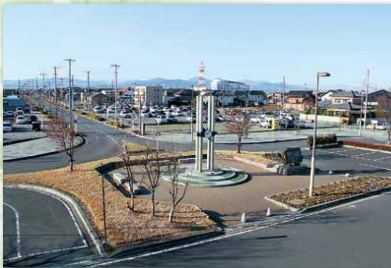
▼役場庁舎屋上より
