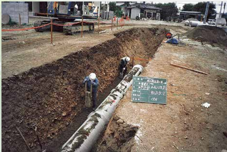
▼三田久保原線(雨水管布設)
