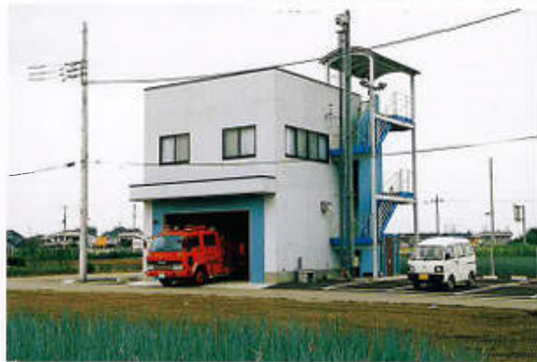
▲上里町消防団第4分団消防車庫
