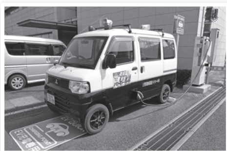
▲電気自動車急速充電設備
