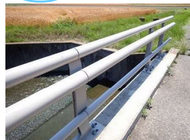
補修後 防護柵を取替え
