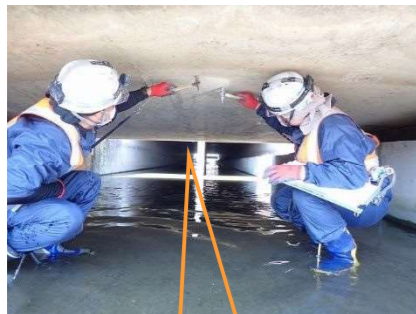
専用のハンマーで コンクリートを打音検査
