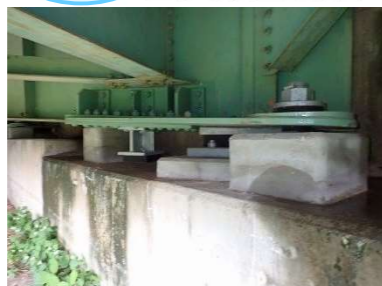
補修後 地震時の落橋を防止する装置を設置
