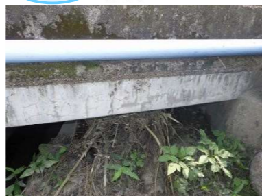
補修後 剥落した断面の修復
