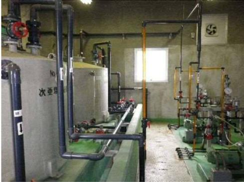
写真 上里第二浄水場次亜注入設備
