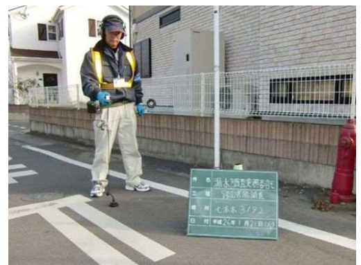
写真 漏水調査状況
