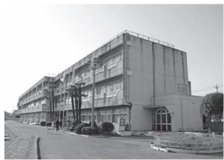
改修予定の七本木小学校
