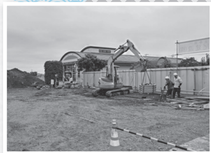
▲長幡児童館・公民館改修工事
