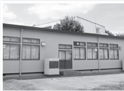
▲上里東小学校特別教室棟の改修工事
