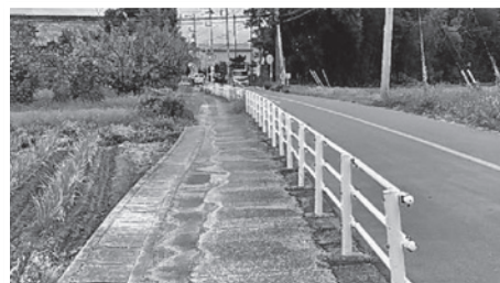
歩道整備を進める藤木戸勝場線
