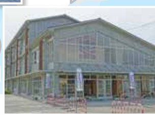
平成25年11月 上里中学校 新校舎棟完成
