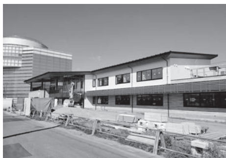
こむぎっちテラス工事の様子
