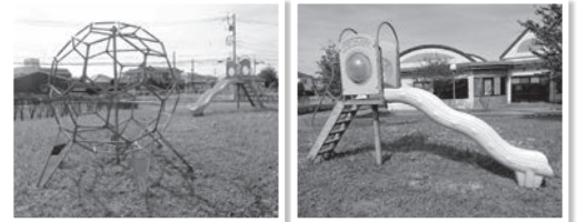
遊具の更新工事を行う長幡児童公園
