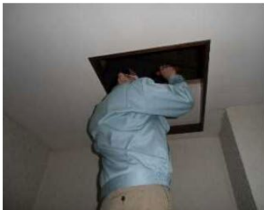
「小屋組・梁」調査の様子
