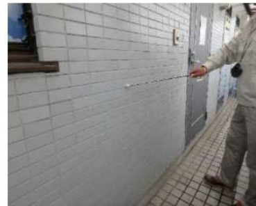
「外部（外壁）」調査の様子
