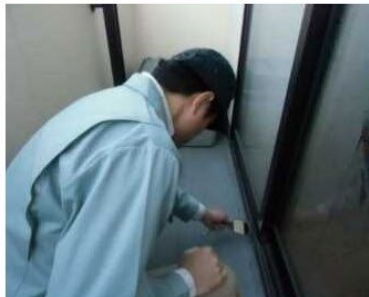
「外部（バルコニー）」調査の様子
