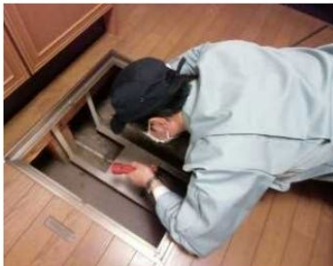
「土台・床組、基礎」調査の様子
