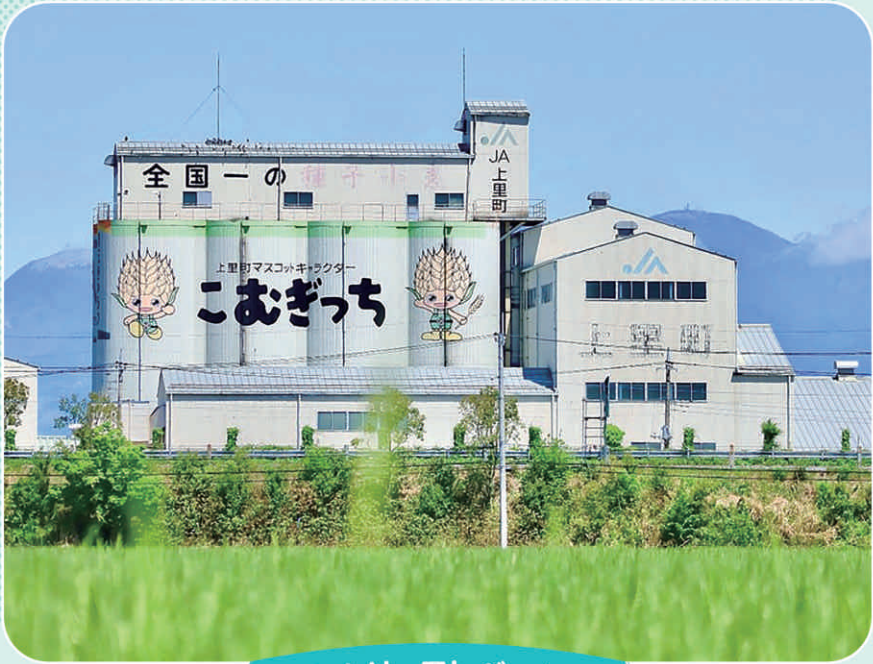
カントリーエレベーター
