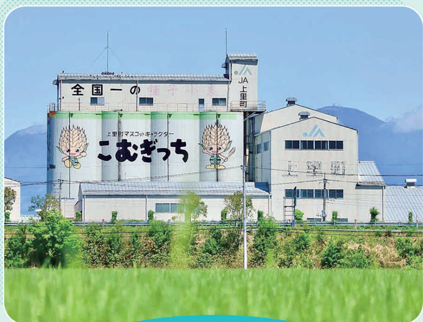
カントリーエレベーター
