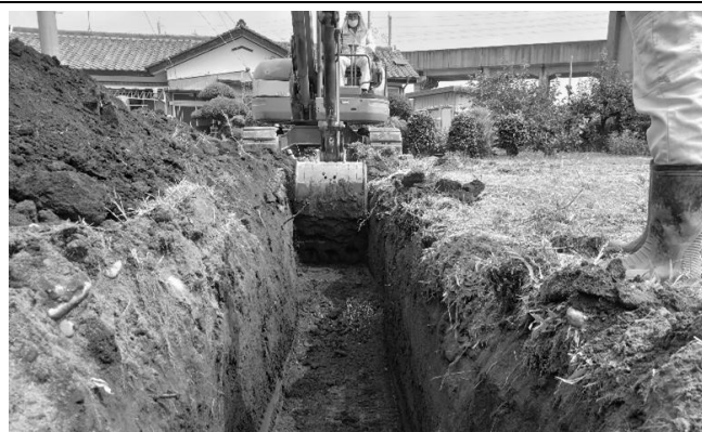
試掘調査（上里町No.16 遺跡）
