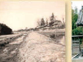
金窪城跡 昭和32年頃の掘削写真
