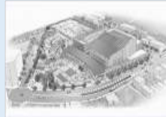
拠点施設誘致事例： 川越市西部地域振興ふれあい拠点施設（埼玉県HPより）
